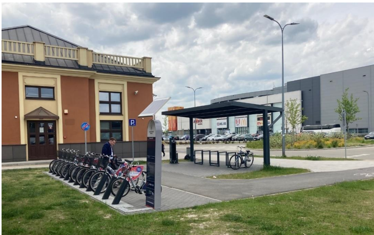
Zdjęcie 3. Parking rowerowy przy dworcu kolejowym w Kaliszu pełniący funkcje B&R 1 .
