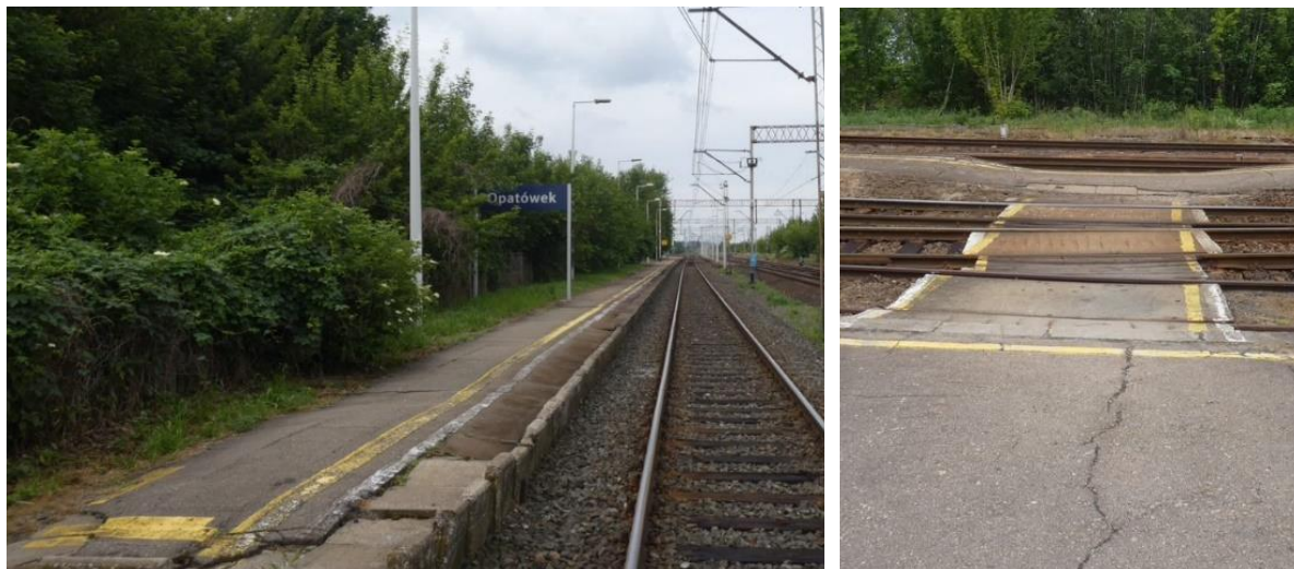
Zdjęcie 22. Zły stan techniczny nawierzchni peronowej na stacji kolejowej w Opatówku.
