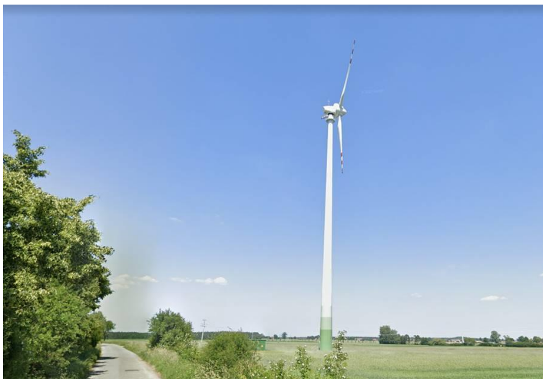
Ryc. 4.1.11. Turbina wiatrowa w miejscowości Brzezie w gminie Pleszew. Źródło: Google street view.
